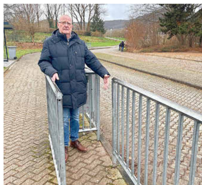
Sieht hier Verbesserungsbedarf: Martin Rosowski am Geländer, das seiner Meinung nach zu schmal ist und Schüler eher gefährdet und einquetscht.
